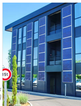
Façade d'entreprise avec panneaux photovoltaïques (batirama)
