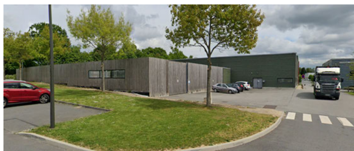
Aire de stockage – ZA de Vitré
